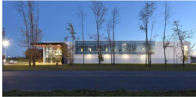
Urecon, Quebec, Kanada
